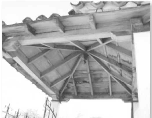
Gráfica 17: Detalle de la cubierta de madera del vestíbulo.
